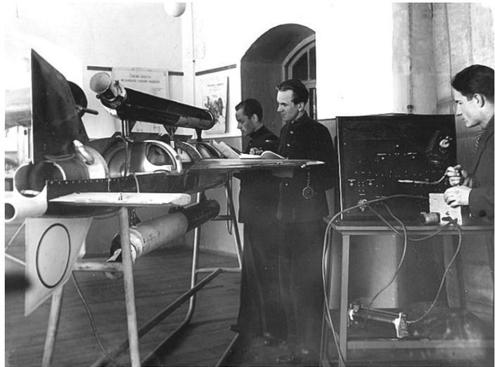
*Рис. 4 Лабораторная работа на учебно-разрезной зенитной ракете «Шметтерлинг». Конец 1940-х годов.*
